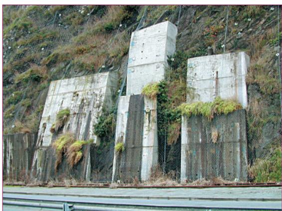
Fig. 10 - Perturbation des écoulements d'eau due au colmatage des drains par la végétation, avec risque de mise en charge hydraulique (Brest).
