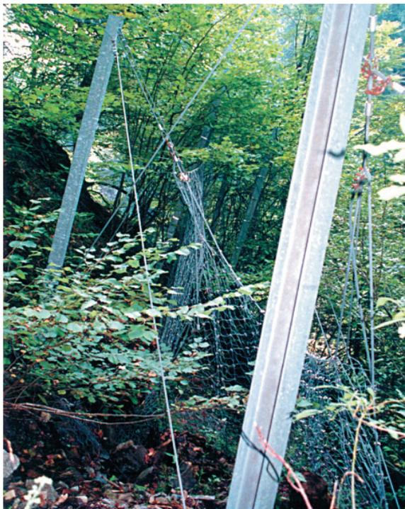
Fig.17 - Cet écran pare-blocs a été sollicité avec un niveau d'énergie sensiblement supérieur à son SEL, sans toutefois atteindre le MEL. La hauteur résiduelle de l'ouvrage étant insuffisante pour contrôler un événement identique (perte de plus de 50 %), une reconstruction est à programmer (Tarentaise).
