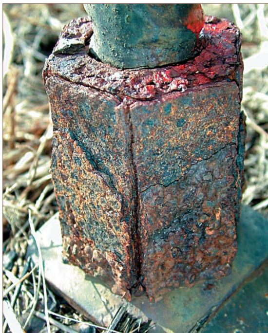
Fig.9 - Exemple de corrosion extrême d'un écrou d'ancrage dans une zone exposée à des embruns marins.
