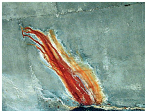
Fig. 8 - Signes de corrosion des armatures d'une galerie pare-blocs consécutive à une fissuration du béton favorisant les circulations d'eau dans le béton.
