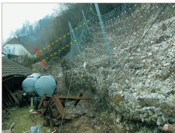
Fig. 16 - Cet écran pare-blocs a été sollicité avec de faibles niveaux d'énergie, mais avec une fréquence d'apport de matériaux élevée. Le taux de remplissage de l'ouvrage a atteint son maximum et on note une réduction sensible de la hauteur de l'ouvrage (flèche rouge). Un curage doit être envisagé pour lui rendre sa fonctionnalité (Ste Suzanne, 2003).
