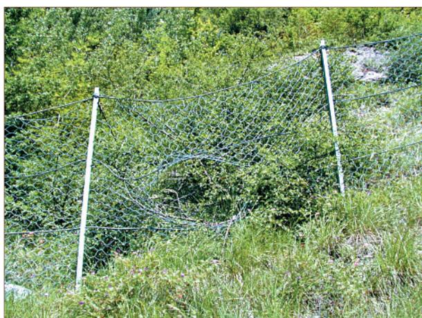
Fig. 20 - La barrière grillagée a été perforée par un bloc trop énergétique pour ce type d'ouvrage. Il s'avère que la protection n'était pas adaptée à l'aléa. Un autre ouvrage de capacité supérieure devrait être envisagé. À défaut, l'écran doit être réparé pour l'interception de pierres faiblement énergétiques (Tarentaise).
