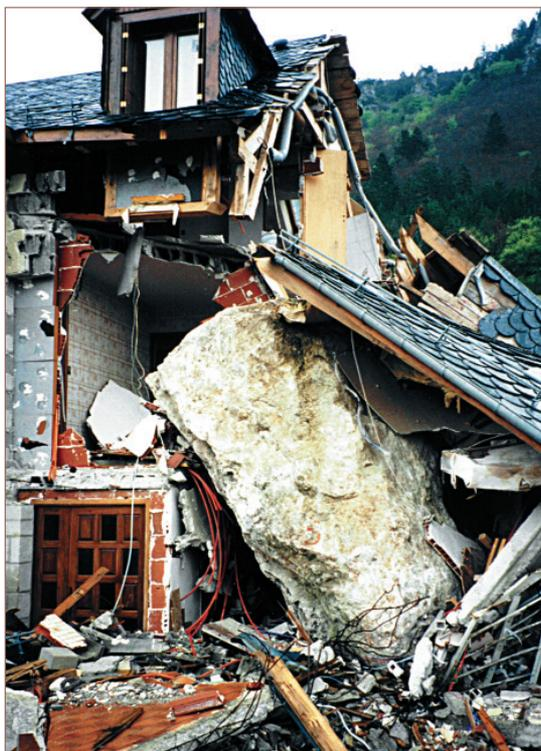
Fig. 4 - Habitation de Barjac détruite par un éboulement. Suite à cet événement, des travaux de protection par merlon d'arrêt ont été réalisés pour la protection du village vis-à-vis d'autres aléas identifiés.
