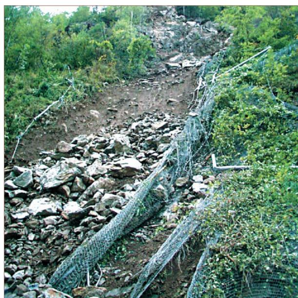
Fig. 21 - Un éboulement très volumineux a détruit l'écran pare-blocs disposé dans le versant. Le MEL a été dépassé et l'ouvrage n'a pas pu remplir son rôle. Après analyse du risque résiduel, une nouvelle protection devra être définie, si possible (Alpes-Maritimes).
