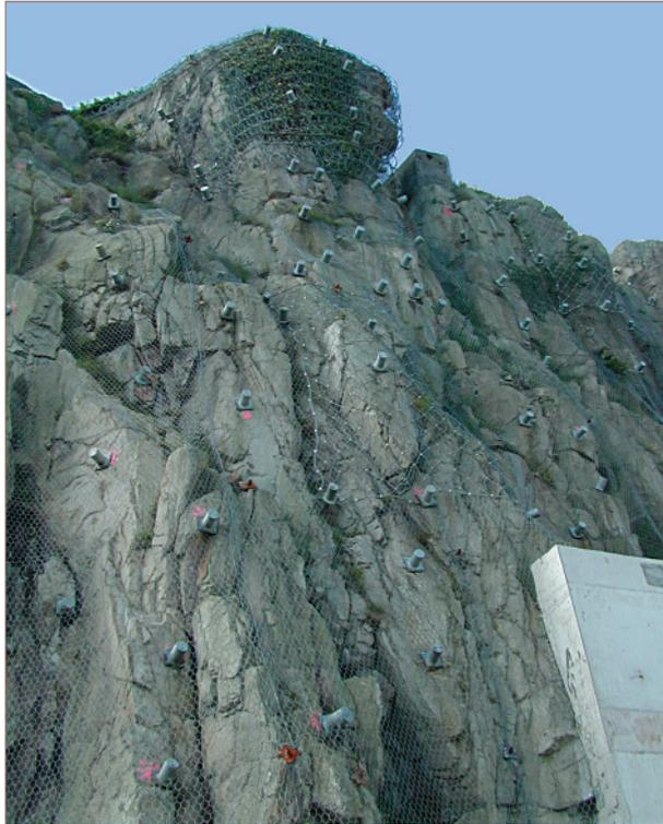
Fig. 23 - Capots de protection des têtes d'ancrage à fort impact visuel. Ce type de matériel peut être toléré sur certains sites, mais non généralisé (ici, un site militaire protégé).
