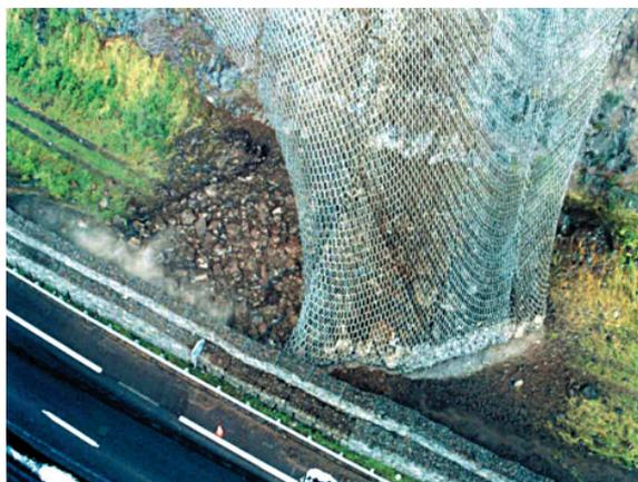
Fig.19 - Ce filet métallique pendu a été sollicité aux limites de ses possibilités. L'éboulement a été contrôlé mais l'ouvrage n'est plus en mesure d'assurer à nouveau ses fonctions. Une restauration est à réaliser (La Réunion).
