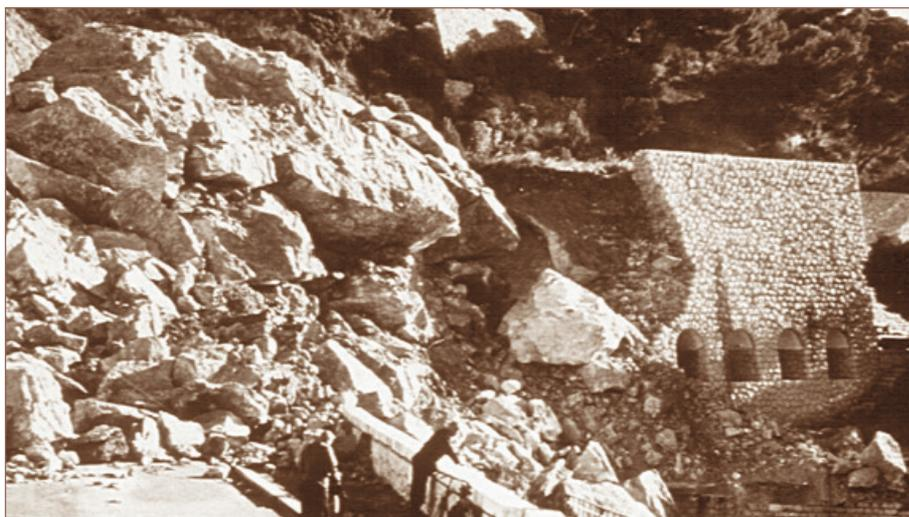
Fig. 1 - Écrasement d’une galerie pare-blocs par éboulement en masse. Eze (Alpes-Maritimes) - 1948
