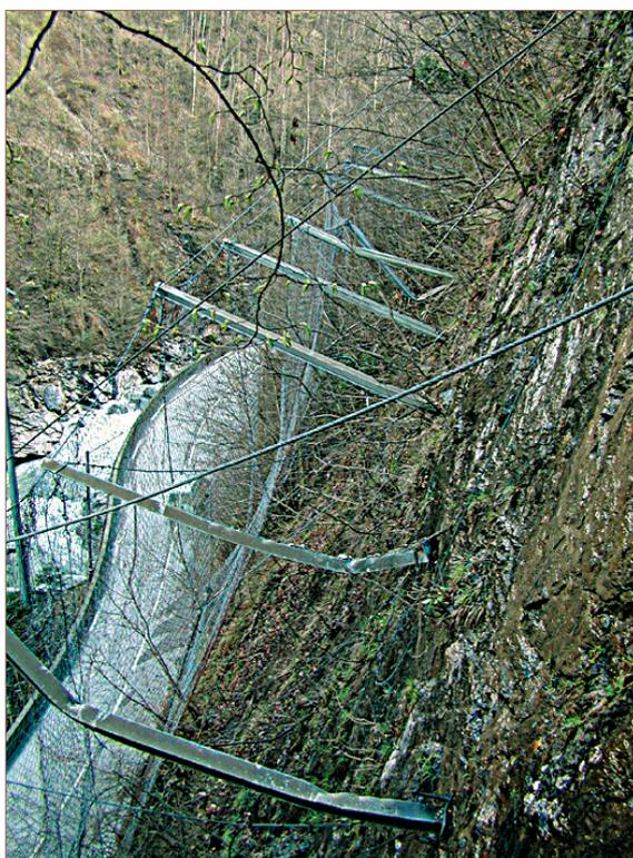
Fig. 15 - Dans cet exemple de grillage pendu sur poteaux fortement sollicité, on note la déformation des poteaux qui réduit la hauteur d'interception de l'ouvrage dans des proportions acceptables (quelques décimètres) mais qui, à terme, pourra induire une corrosion de l'acier. Par contre, la fonctionnalité de l'ouvrage, malgré son aspect dégradé, n'est pas remise en question (Val d'Arly).
