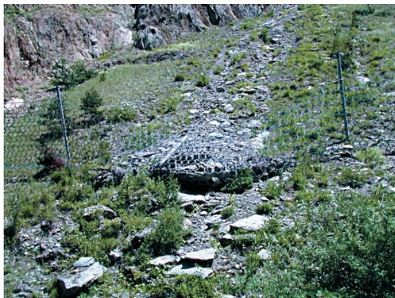
Fig.18 - L'éboulement qu'a subi cet écran pare-blocs a provoqué l'effacement d'un support. La hauteur résiduelle de l'ouvrage est nulle et un nouvel événement, même minime, ne pourrait être contrôlé. L'ouvrage (qui a parfaitement rempli son rôle) est à reconstruire (Tarentaise).
