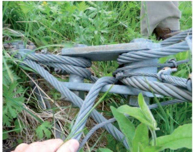
Cliché 23 : Système de liaison ancrage filet type EI.
