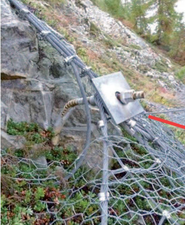
*Cliché 20 : Pièce de liaison ancrage filet induisant des contraintes et déformations en cisaillement sur la barre de scellement.*
