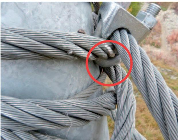
Cliché 6 : un serre-câble en appui sur le poteau créant une déformation du poteau
