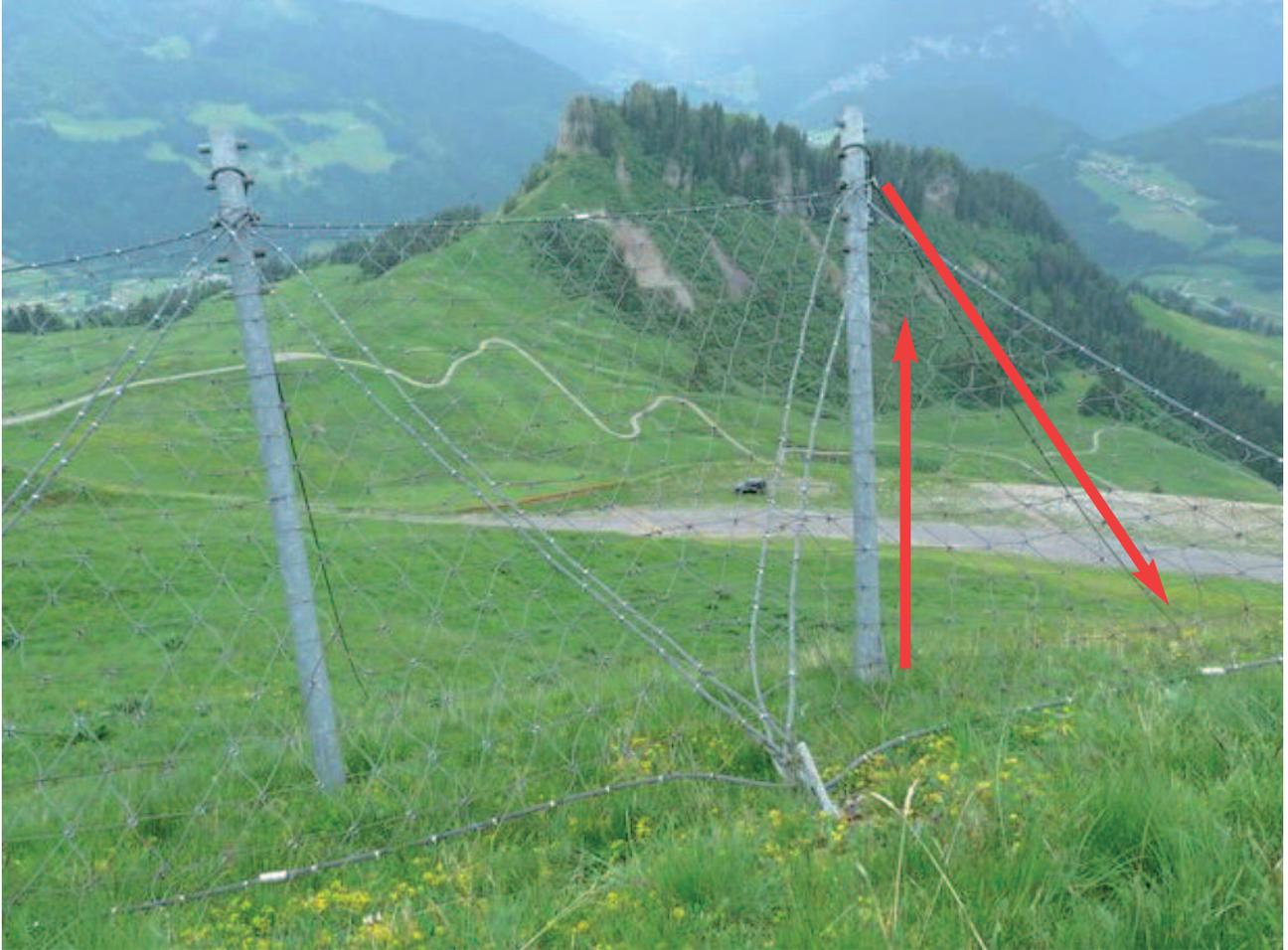
*Cliché 12 : rejet du poteau d'extrémité de ligne vers l'extérieur, le hauban aval est décalé sur le côté.*
