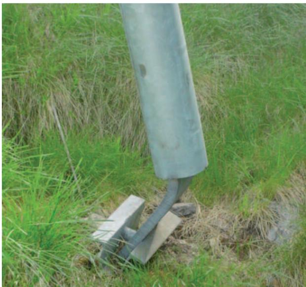
Sur la photo ci-dessous, il convient de prévoir une évacuation des eaux de l'intérieur du tube et de la coupelle. Il est possible pour bloquer le pied du poteau de poser un crayon d'ancrage de diamètre 16 mm.
