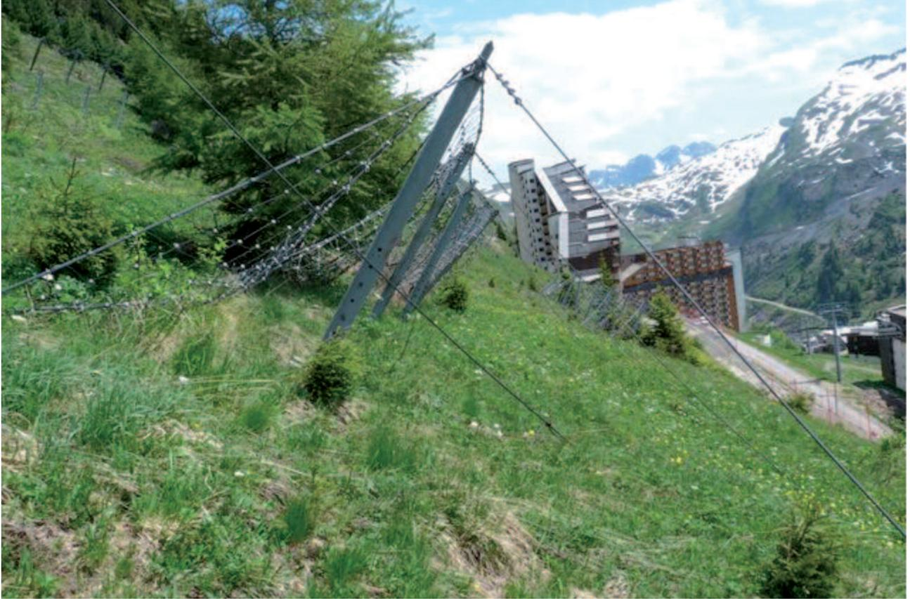
Cliché 54 : Géométrie des filets, rupture d'ancrage et réglage des haubans aval.
