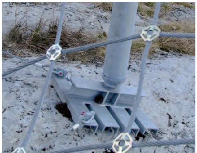
Large platine de filet Geobrugg avec rotule articulée
