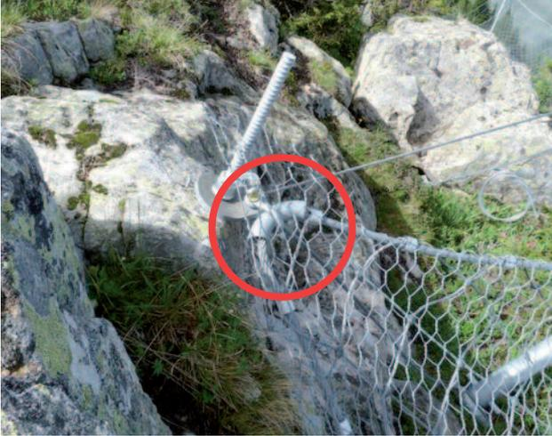
*Cliché 25 : Dispositif de liaison ancrage filet par manille avec pièce de renfort du filet pour le respect des rayons de courbures.*
