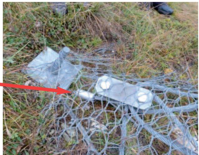
*Correction par l'ajout d'un boucle de câble manchonné. On ne peut pas vérifier le respect du rayon de courbure sous la plaque.*
