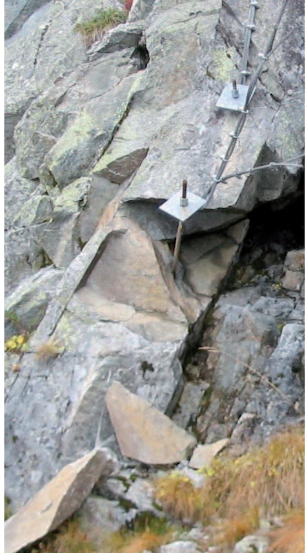
Cliché 5 : dégagement d'un ancrage par action du gel dégel sur la roche
