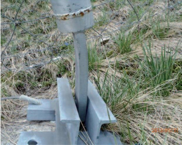
Cliché 5 : Désordre de poteau au niveau de la liaison avec la platine en raison du positionnement du pied de poteau.
