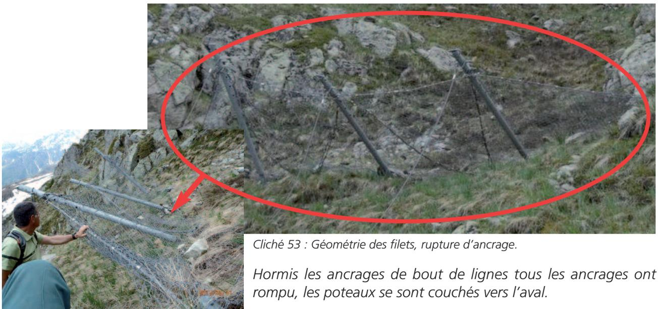
Cliché 53 : Géométrie des filets, rupture d'ancrage.
