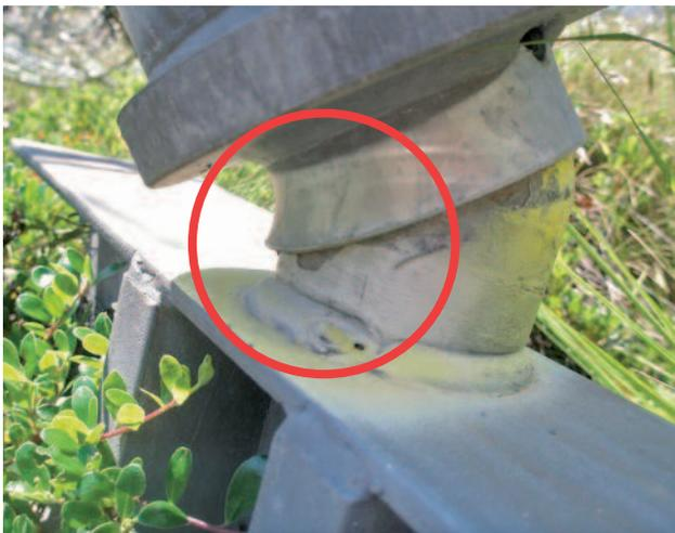
Cliché 28 : Rupture au niveau de la platine
