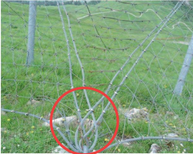
Cliché 14 : rupture de pièces adaptées pour le respect des rayons de courbure
