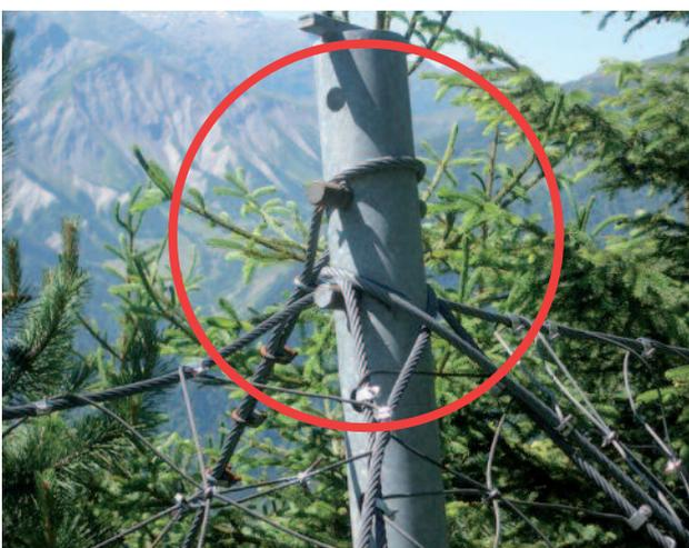
Cliché 2 : sommet de poteau d'un F36 modèle 1990 – bonne disposition avec décalage d'un trou pour le haubanage
