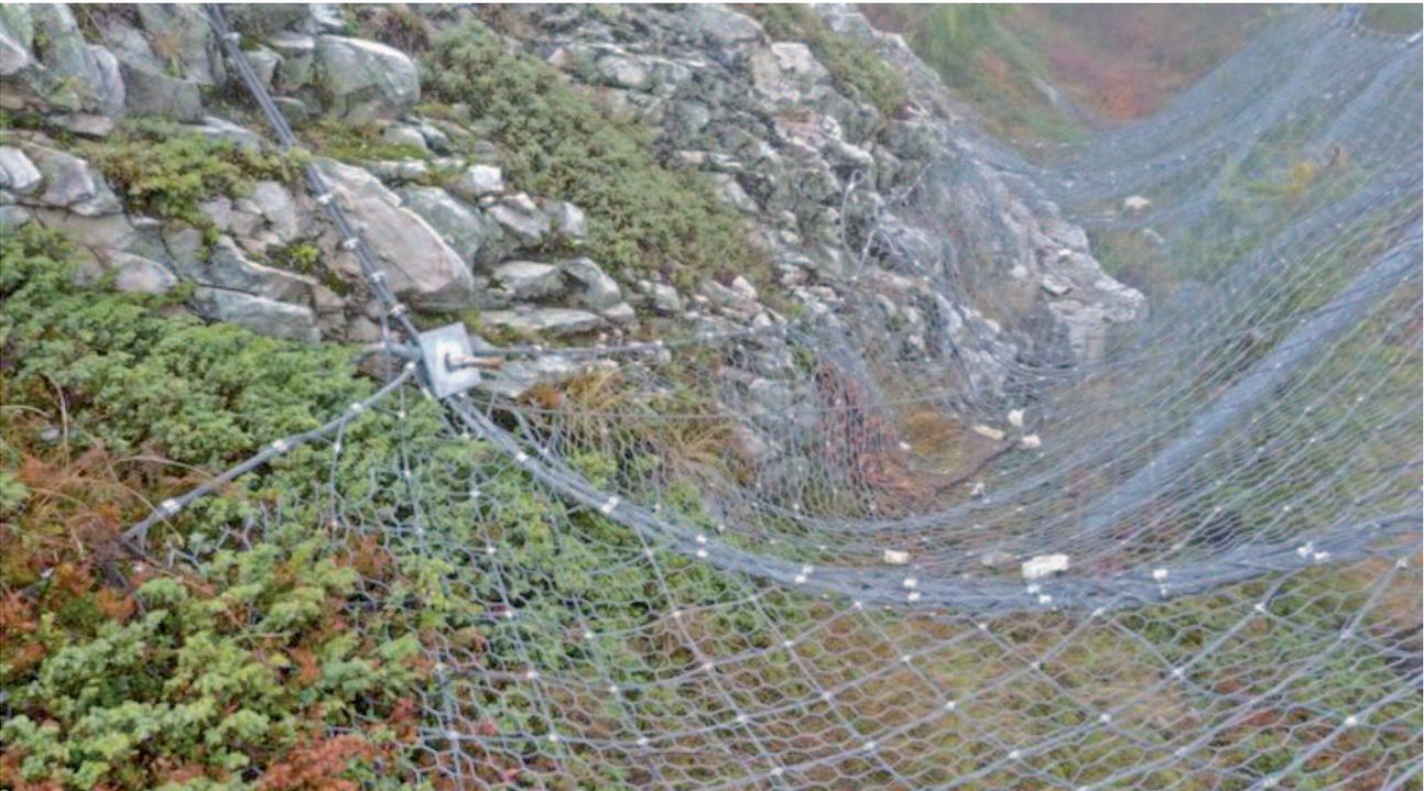
Cliché 62 : Géométrie des filets, poteaux trop inclinés et filet trop détendu
