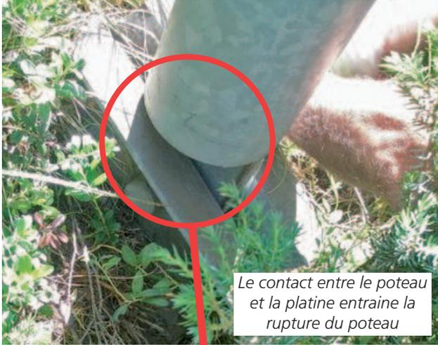
Le contact entre le poteau et la platine entraîne la rupture du poteau
