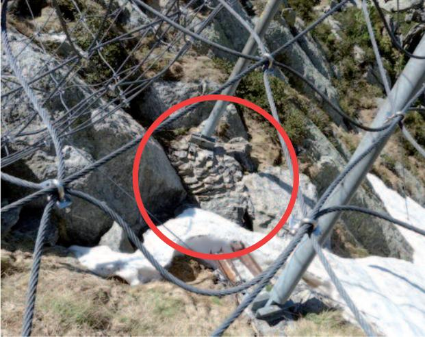
Cliché 10 : aménagement en pied de poteau d'une maçonnerie de pierre pour récupérer la dénivelé du terrain.
