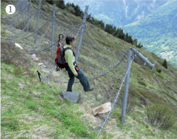
Cliché 1: Ruptures de poteaux au niveau du haubanage, soit par les efforts du hauban aval (1 et 2) soit par étranglement par le câble de pourtour du filet (3) ;=> poteaux à changer
