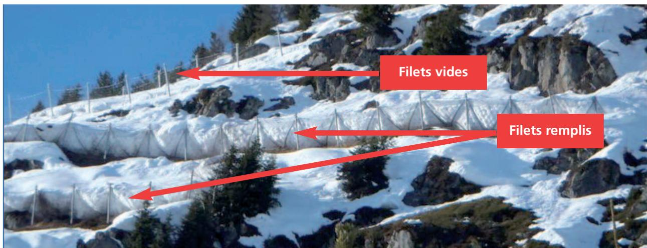
Cliché 4 : Frumezan - St Colomban des Villards, chargement hétérogène d'un même dispositif
