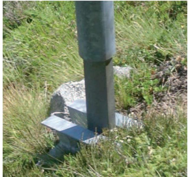
Modèle de platine E1 où le pied de poteau est modifié pour éviter les ruptures par appui sur la platine.
