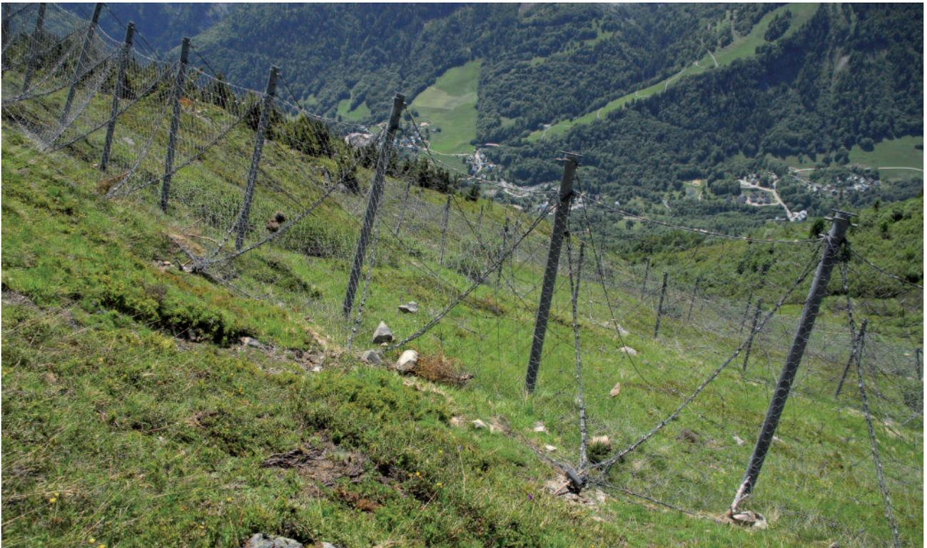
Cliché 52 : Géométrie des filets, rupture d'ancrage.
