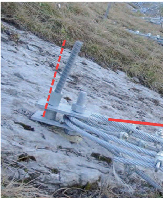
*Correction par une pièce en fer plat coudée et une manille. La manille ne permet pas un bon respect du rayon de courbure*
