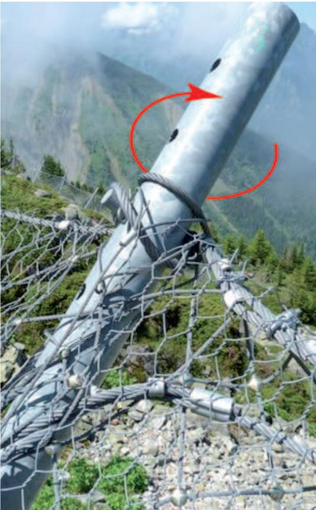
Cliché 11 : décrochement de câble des axes du poteau
