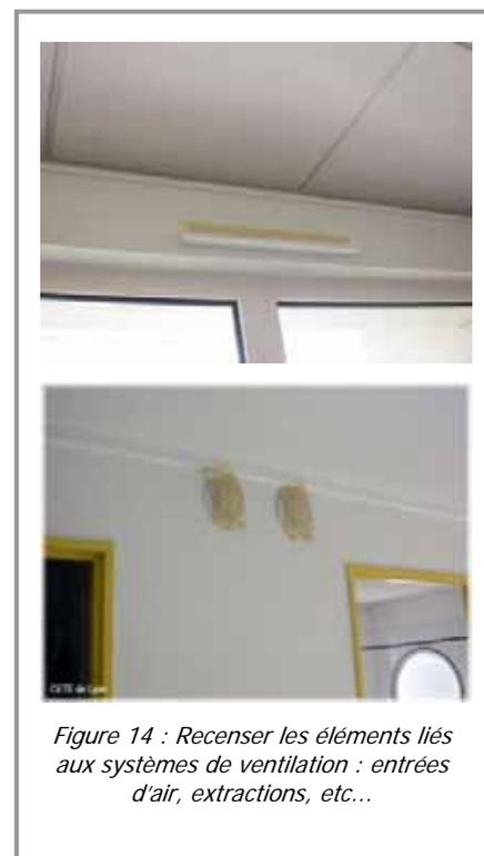
Figure 14 : Recenser les éléments liés aux systèmes de ventilation : entrées d'air, extractions, etc...
