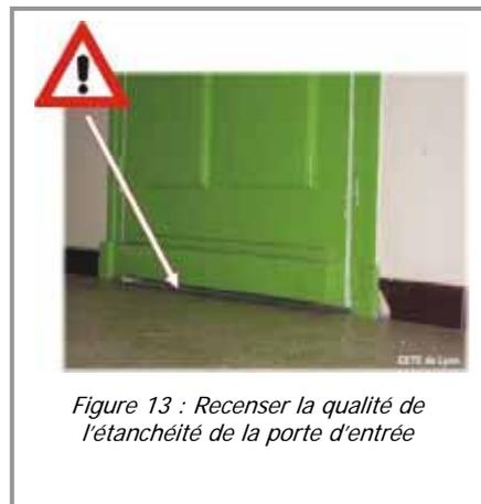
Figure 13 : Recenser la qualité de l'étanchéité de la porte d'entrée
