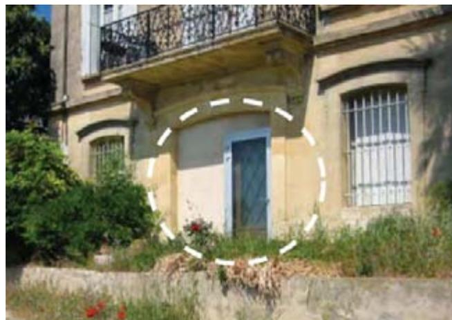
*Réduction de la surface d'ouverture et mise en place d'une double porte*
