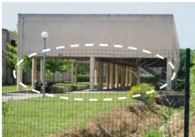
*Collège : le rez-de-chaussée offre une transparence maximale, et les salles de cours sont sur pilotis.*
