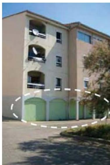
*Le rez-de-chaussée est utilisé pour des parkings, réduisant ainsi les enjeux humains*
