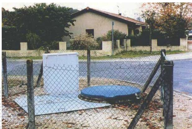
Un poste de refoulement des eaux usées à Cadaujac (Gironde). Risque de submersion sous 1,50 m pour une crue centennale.
