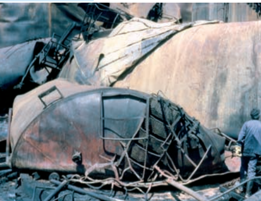
Fig. 11 - Bac d'hydrocarbure après une explosion interne
