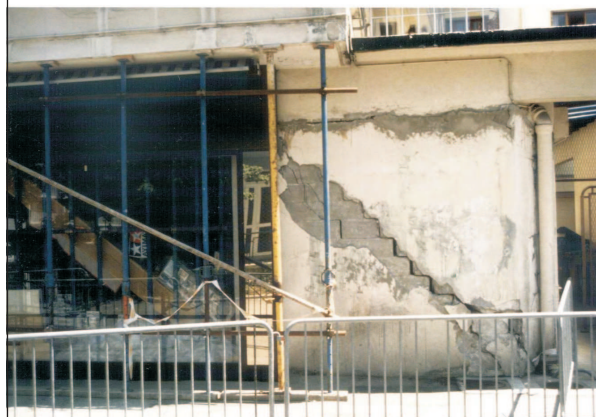
Façade en rez de chaussée à Meythet
