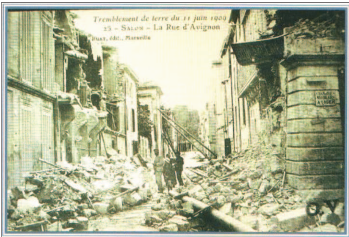
Photographie 2 : Dégâts du séisme de Lambesc à Salon (Bouches-du-Rhône), 1909
