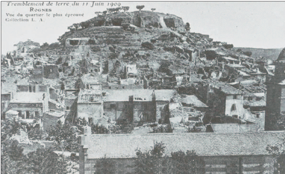
Photographie 5 : Effet de site topographique consécutif au séisme de Lambesc à Rognes (Bouches-du-Rhône), 1909
