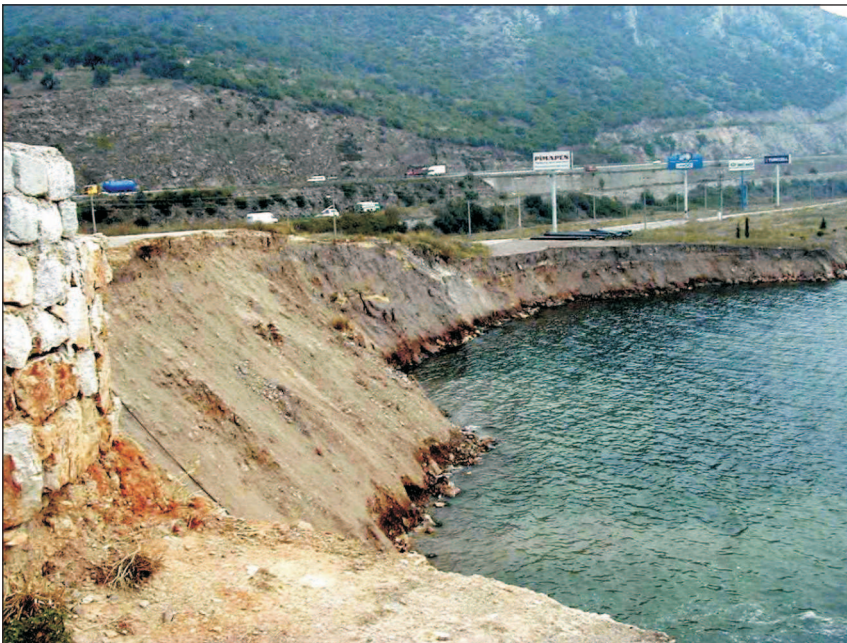
Photographie 12 : Mouvement de terrain lié au séisme de Kocaeli, Izmit, (Turquie) 1999
