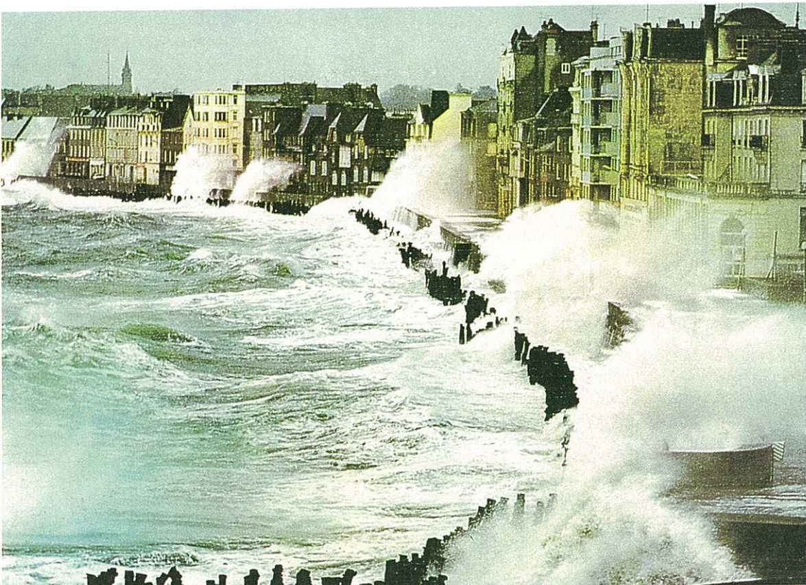
Photo 5. Franchissement en tempête à Saint-Malo (Côtes-d'Armor)
