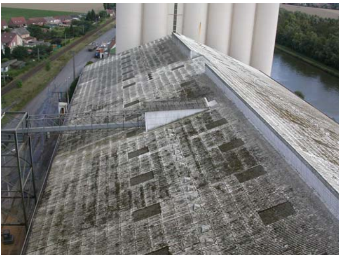
Figure 13 : Couverture en fibrociment
