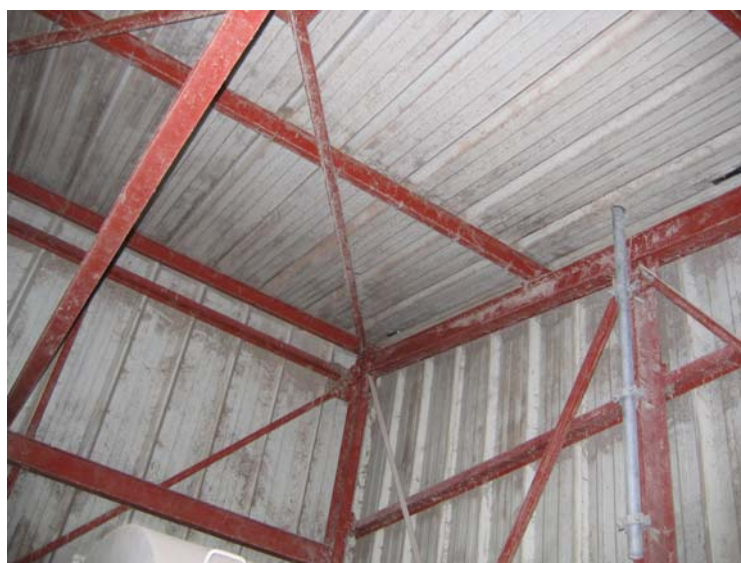
Figure 11 : Bardage simple peau
