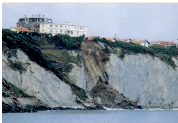
Érosion à falaises Biarritz (Pyrénées Atlantiques)
