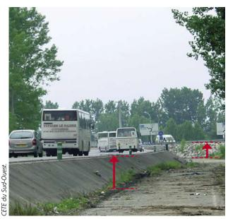
Surélévation de route. À la sortie de Marmande, direction Bordeaux, la route est mise hors d'eau (surélevée sur un remblai bétonné) pour les crues de la Garonne.
