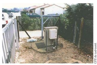
Un poste de refoulement des eaux usées à Cadaujac (Gironde). Risque de submersion sous 20 cm pour une crue centennale.
