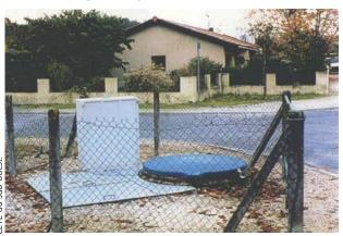
Un poste de refoulement des eaux usées à Cadaujac (Gironde). Risque de submersion sous 1,50 m pour une crue centennale.
