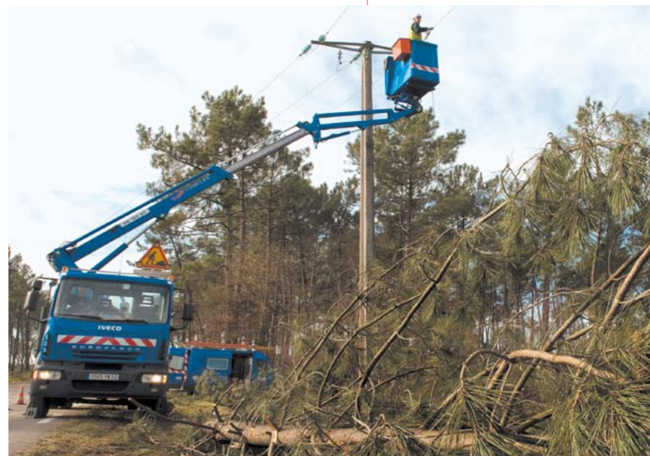
Réparation du réseau électrique après le passage de la tempête Klaus
