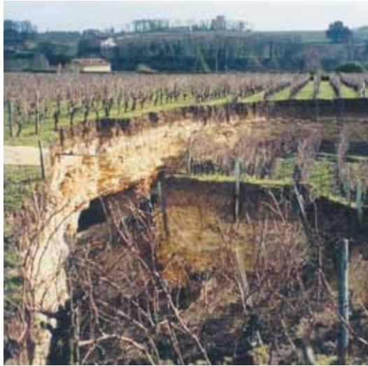
Exemple d'un effondrement en masse – Saint-Émilion (conseil général 33)
