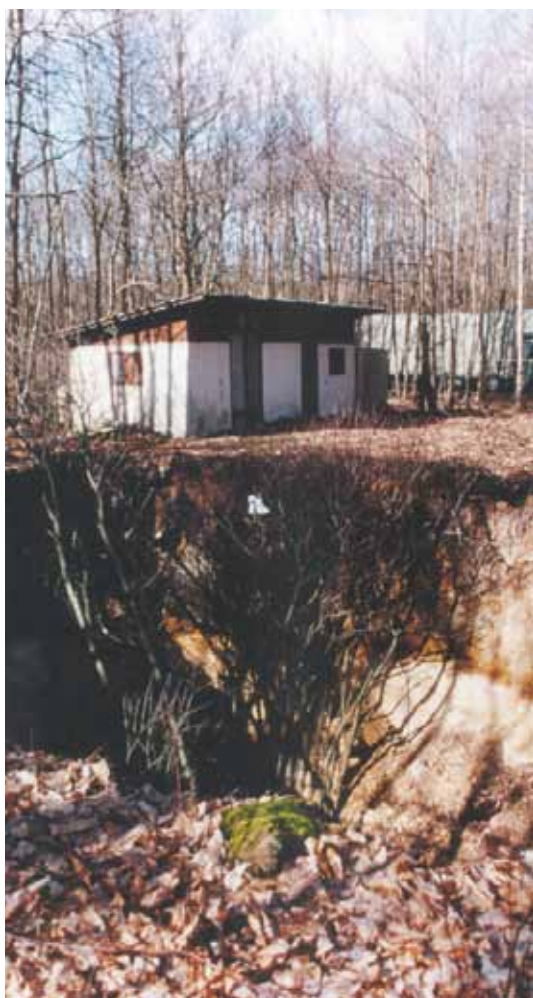
Conséquences d'un fontis en surface (INERIS)
