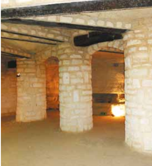
Confortements massifs d'une cavité
