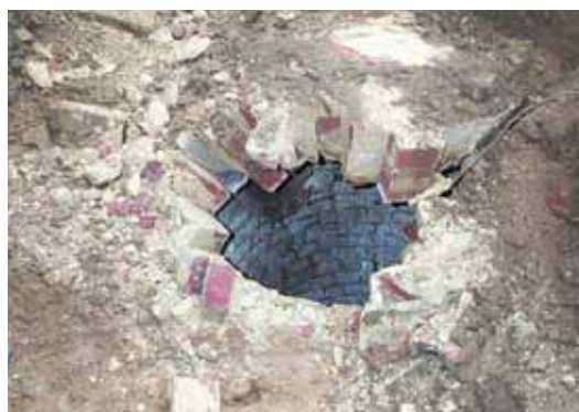
Exemples d'effondrement localisé lié à la rupture d'un puits d'accès de marnière (INERIS, CETE)
