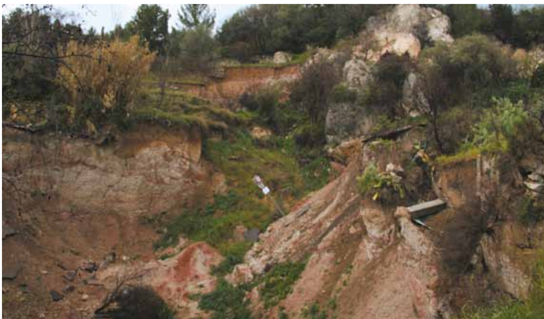
Cassures en bordure d'effondrement et glissement associé en amont d'une zone effondrée (INERIS)
