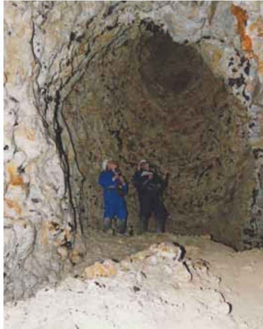
Développement d'une cloche de fontis (INERIS)
