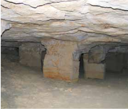
Ancienne exploitation par chambres et piliers (INERIS)
