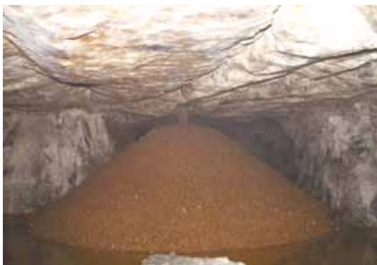
Comblement avec les matériaux sableux laissant circuler l'eau (INERIS)
