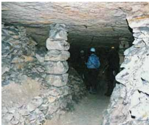
Photo d'une exploitation par hagues et bourrages (INERIS)
