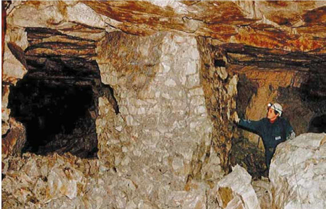
Pilier maçonné dégradé (INERIS)
