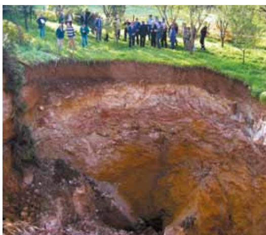
Exemples d'effondrement localisé lié à la rupture de piliers – Tuffeau du Maine-et-Loire et gypse en Provence (INERIS)
