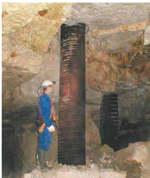
Exemple de pieux traversant une carrière (INERIS)
