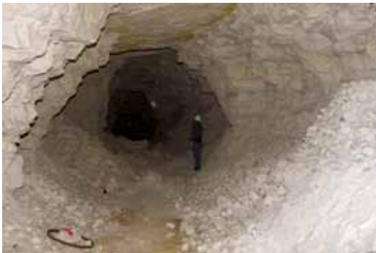
Photos d'une carrière de craie (INERIS)
