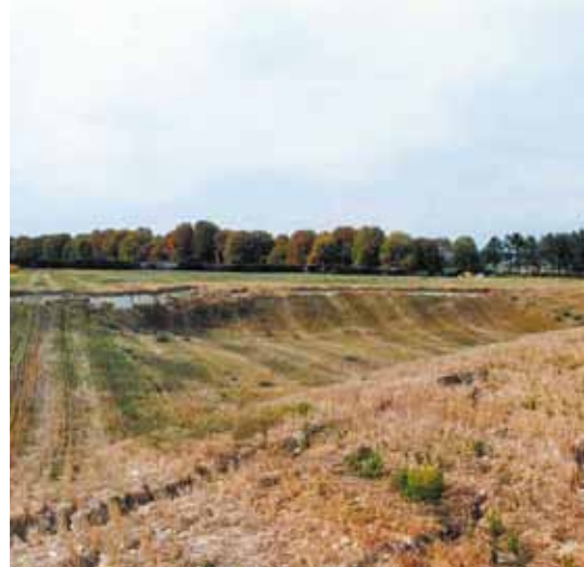
Cuvette créée par un effondrement généralisé (INERIS)
