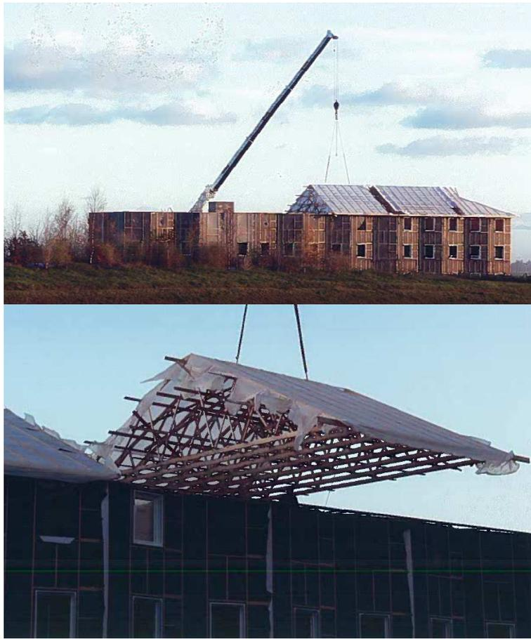
Figure 6-2 : Illustrations du bâtiment en cours de montage
