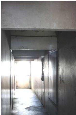
Figure 4-3 : Linteaux visibles au niveau du couloir
