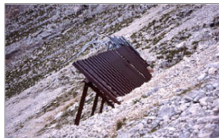
Râteliers paravalanches sous le sommet de Chamechaude (massif de la Chartreuse, Isère)
